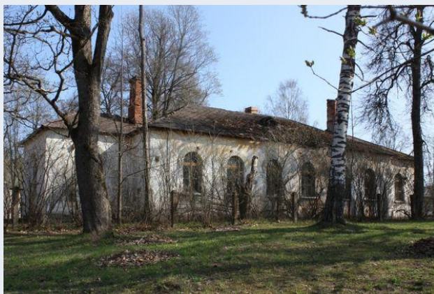
Фото южной стороны церкви. 2011г.
